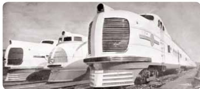
Американские поезда Union Pacific с 1930 г. оснащались произведёнными компанией SKF буксовыми подшипниками, подшипниками для тягового электродвигателя и редуктора. Эти поезда развивали скорость 177 км/ч.
